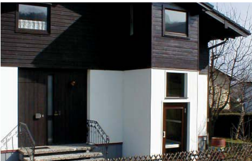
Nachträglich gemauerter Liftanbau mit Isoliertür
