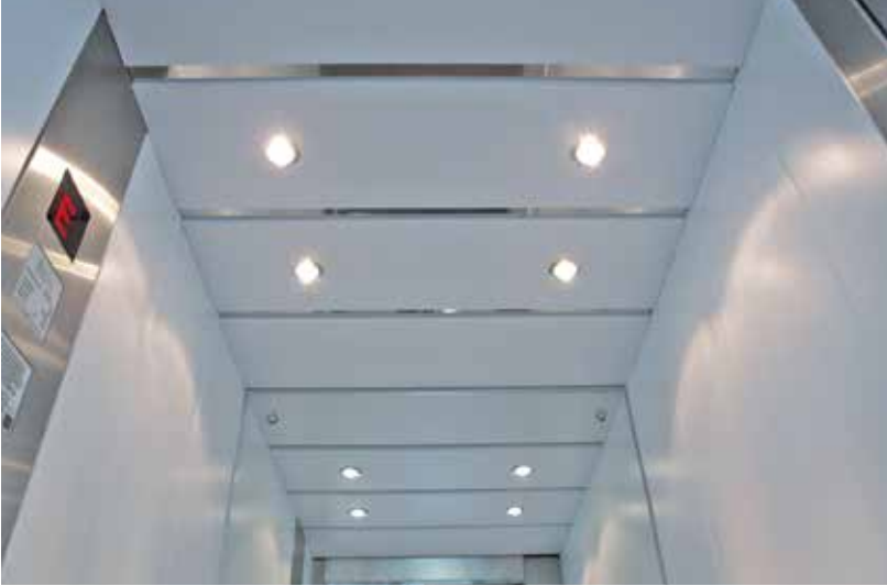
Beleuchtungsart: Einbauspots weiße Decke
