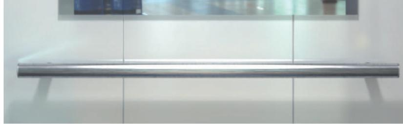
Edelstahl Handlauf Rückwand Korn 240 geschliffen
