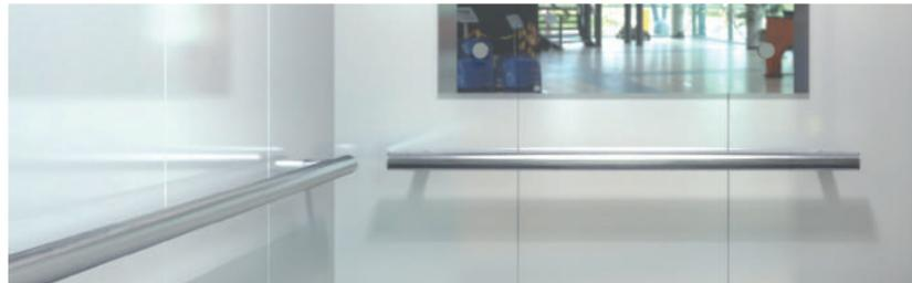
Edelstahl Handlauf Seitenwand und Rückwand Korn 240 geschliffen
